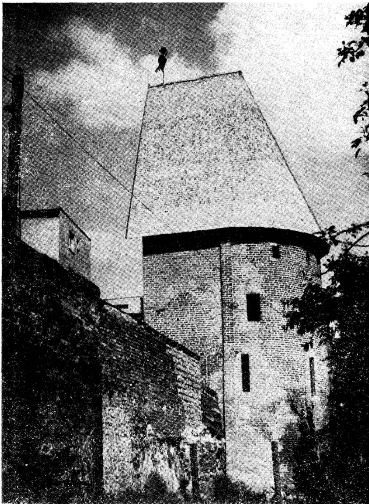
Słupsk — Baszta Czarownic po odbudowie.
