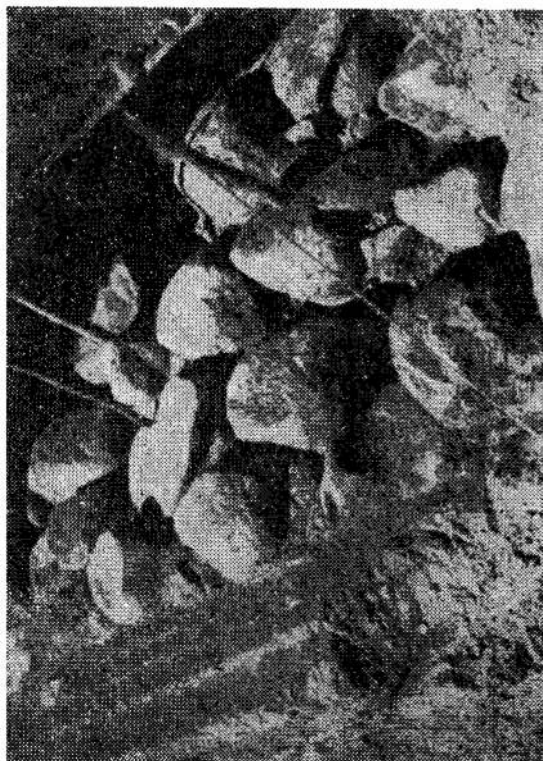
Ryc. 12. Koszalin, Góra Chełmska. Widok na fragment odsłoniętego muru fundamentowego budowli średniowiecznej. Fot. F. Lachowicz
