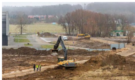
Styczeń – powstanie drogi dojazdowej i zaplecza budowy
