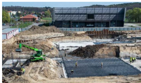
Kwiecień – roboty pod płytę fundamentową budynku głównego
