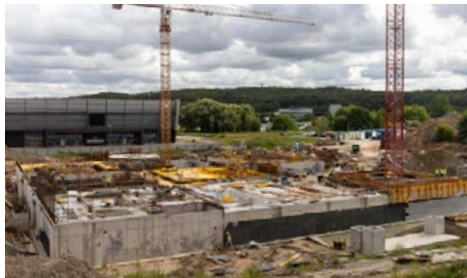
Sierpień – prace żelbetowe pod konstrukcję piwnicy
