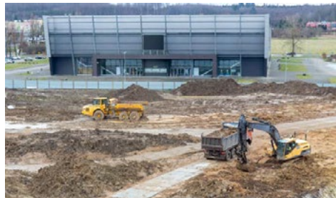
Luty – przygotowanie terenu, roboty ziemne pod fundamenty
