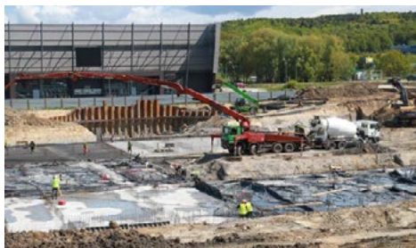
Maj – roboty żelbetowe pod wykonanie konstrukcji piwnicy
