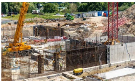
Czerwiec – roboty żelbetowe pod płytę budynku głównego
